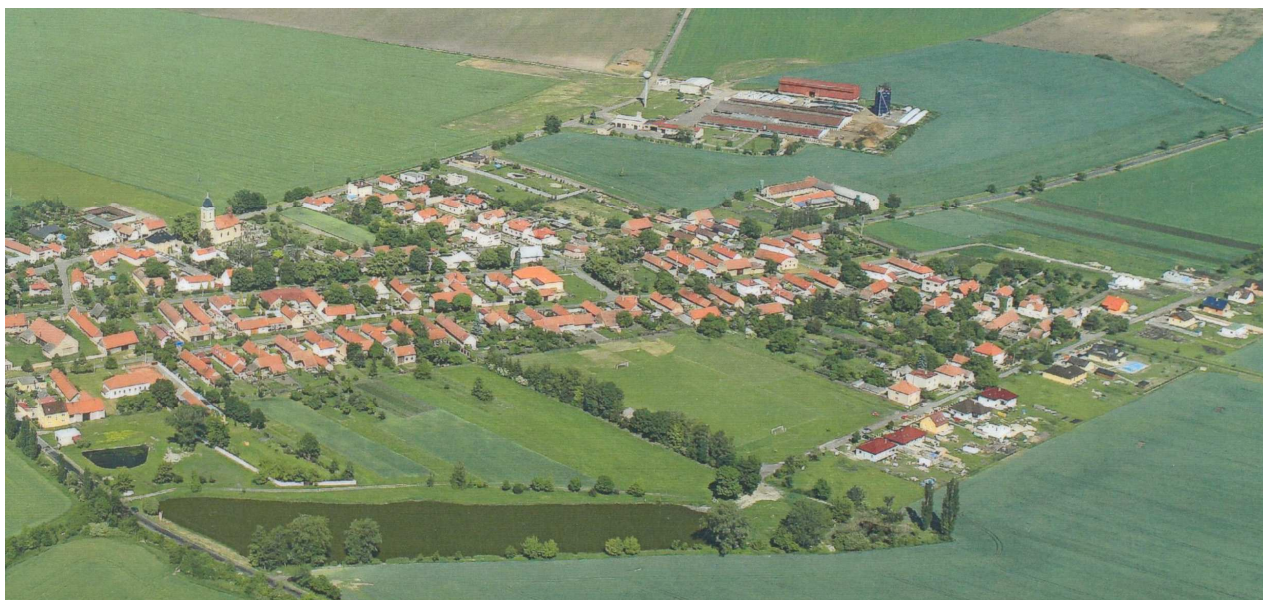
CHLEBY – POHLED OD JZ – PRAVÁ ČÁST
