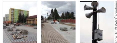
Revitalizace sídliště VI. etapa, rekonstrukce Lipové ulice a nový rozhlas instalovaný po celém městě
