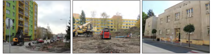
Revitalizace sídliště VI. etapa, hřiště ul. J. Gagarina, Rekonstrukce objektu Hlahol. Foto 3x: Petr Černošous
