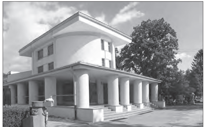
Nymburská budova krematoria. Foto: Jiří Teper
