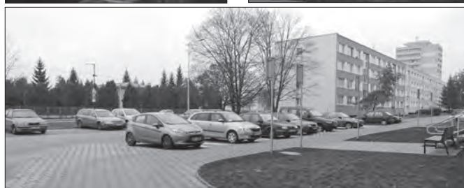
Nová okna ZŠ Tyršova, upravený Mariánský sloup a regenerace panelového sídliště Drahelice. Foto 3x: Petr Černošouš
