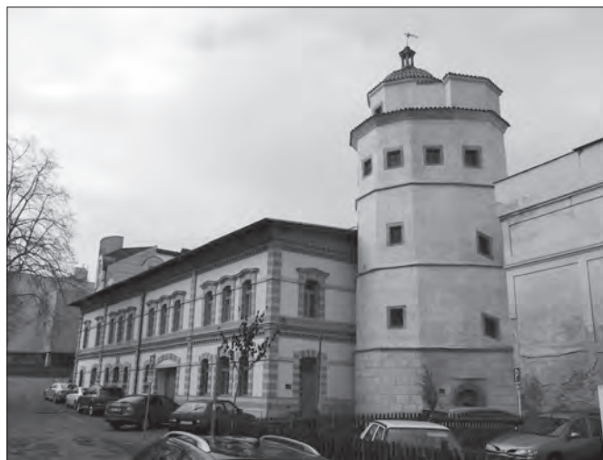
Turecká věž - současná podoba po rekonstrukci v roce 2012. Foto: P. Černošous
